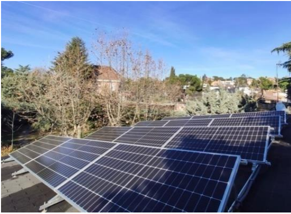
Figura 2. Instalación de paneles solares
